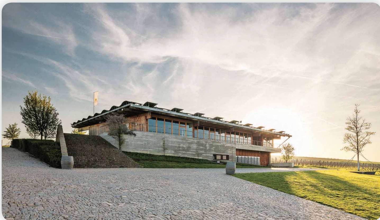
Budovu vinařství navrhl Ing. arch. Josef Pleskot.
