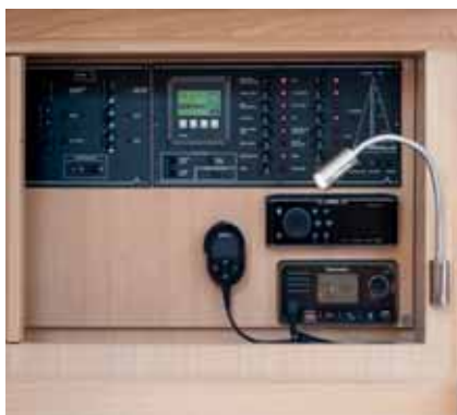
Přístroje u navigačního stolu situované bokem ke směru plavby
