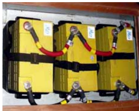
Paralelně zapojené baterie zabezpečené proti pohybu o celkové kapacitě 270 Ah
