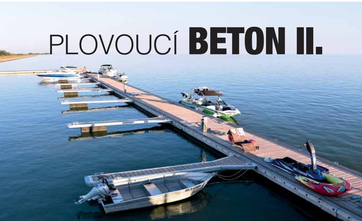
Marina Hamuliakovo kotvená pod vodou řetězy k betonovým blokům, řeka Dunaj
