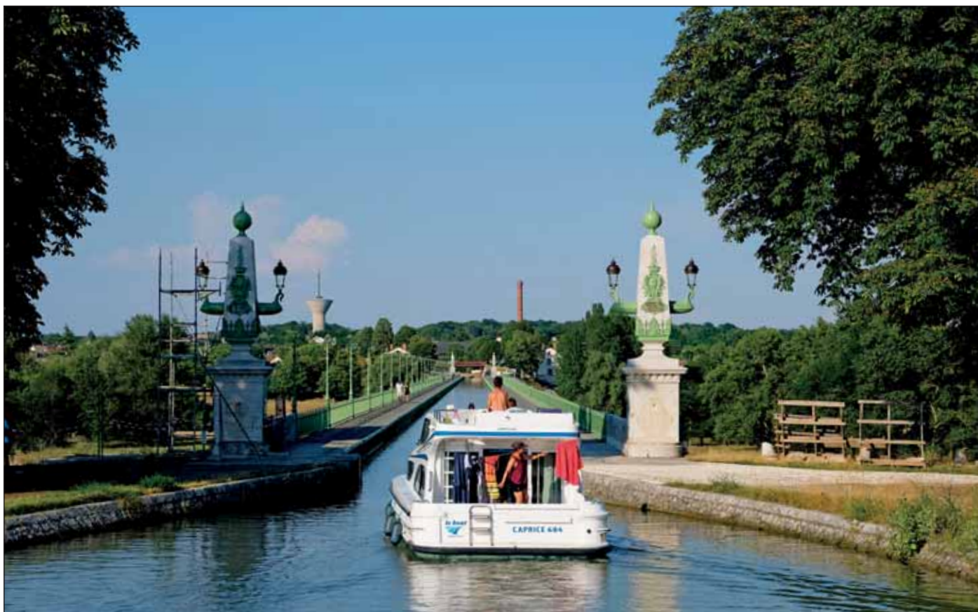
Akvadukt Briare byl postaven přes řeku Loiru v Briare mezi lety 1890 a 1896 inženýrem Abelem Mazoyerem. Stojí na čtrnácti pilířích. Ty spojuje jediný nosník nesoucí žlab s více než 13 000 tuny vody a má hloubku 2,2 metru. Šířka akvaduktu včetně vlečných drah je 11,5 metru a jeho délka je 662,7 metru. Akvadukt je vybaven systémem, který umožňuje jeho vypuštění v případě silných mrazů.
