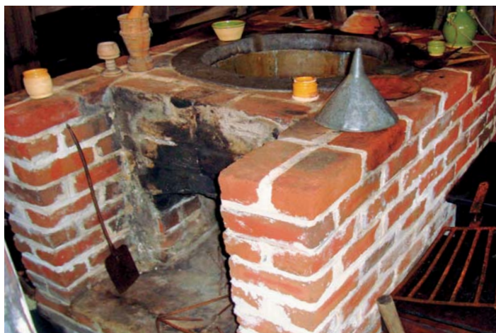
Z cihel vyzdělá kuchyňská kamna se vsazeným kotlem. Zde se muselo každý den připravit nejméně jedno jídlo pro 135 lidí.
