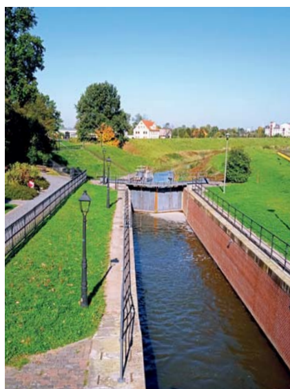
Poslední plavební komora na Odře ve směru na Ostravu byla postavena již v roce 1860 a ovládá se ručně.
